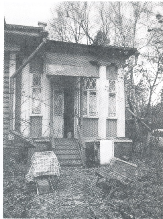
Дача Л.А. Тамбурер в поселке Удельная. 1908-1909. Арх. И.В. Жолтовский. Вход на террасу. Фото автора. 1997.
